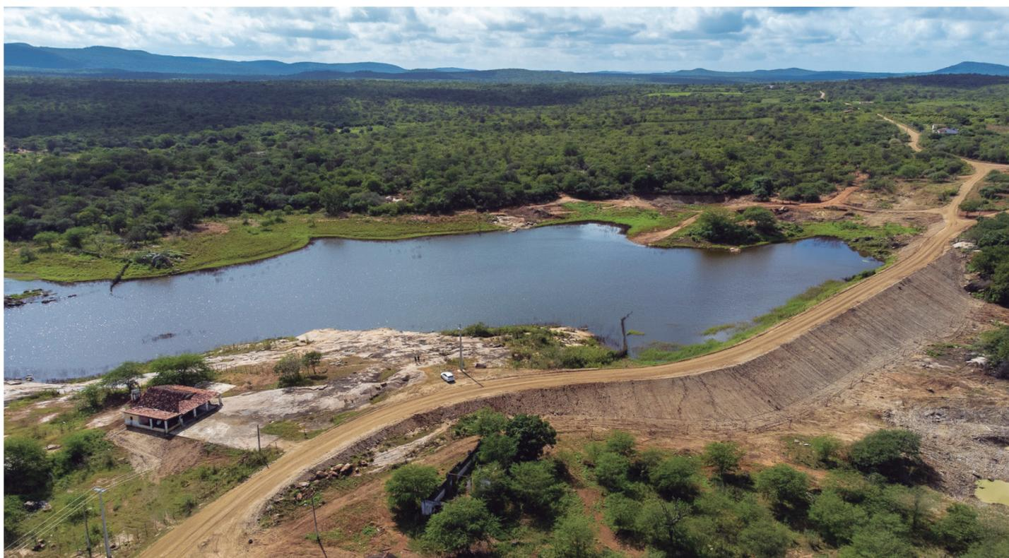
As obras consistem em serviços de limpeza da vegetação, redimensionamento da parede e do sangradouro e drenagem para evitar erosão nos reservatórios
